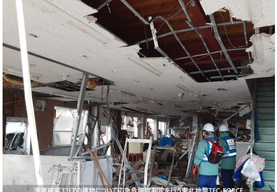
津波被害エリアの建物について応急危険度判定を行う東北地整TEC-FORCE (R6.1.20 石川県珠洲市)
