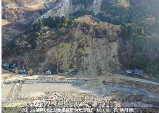
ドローンを活用した土砂崩落箇所の状況確認 (R6.1.16 石川県珠洲市)
