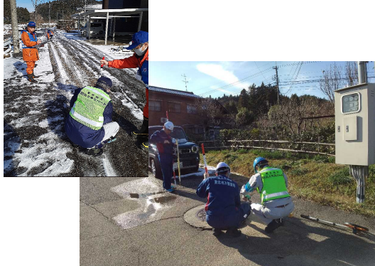
東北地方防災エキスパートと連携した調査 (R6.1.14 石川県穴水町)
