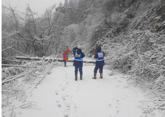
降雪の中、道路の被災状況を調査する東北地整TEC-FORCE (R6.1.13 石川県穴水町)
